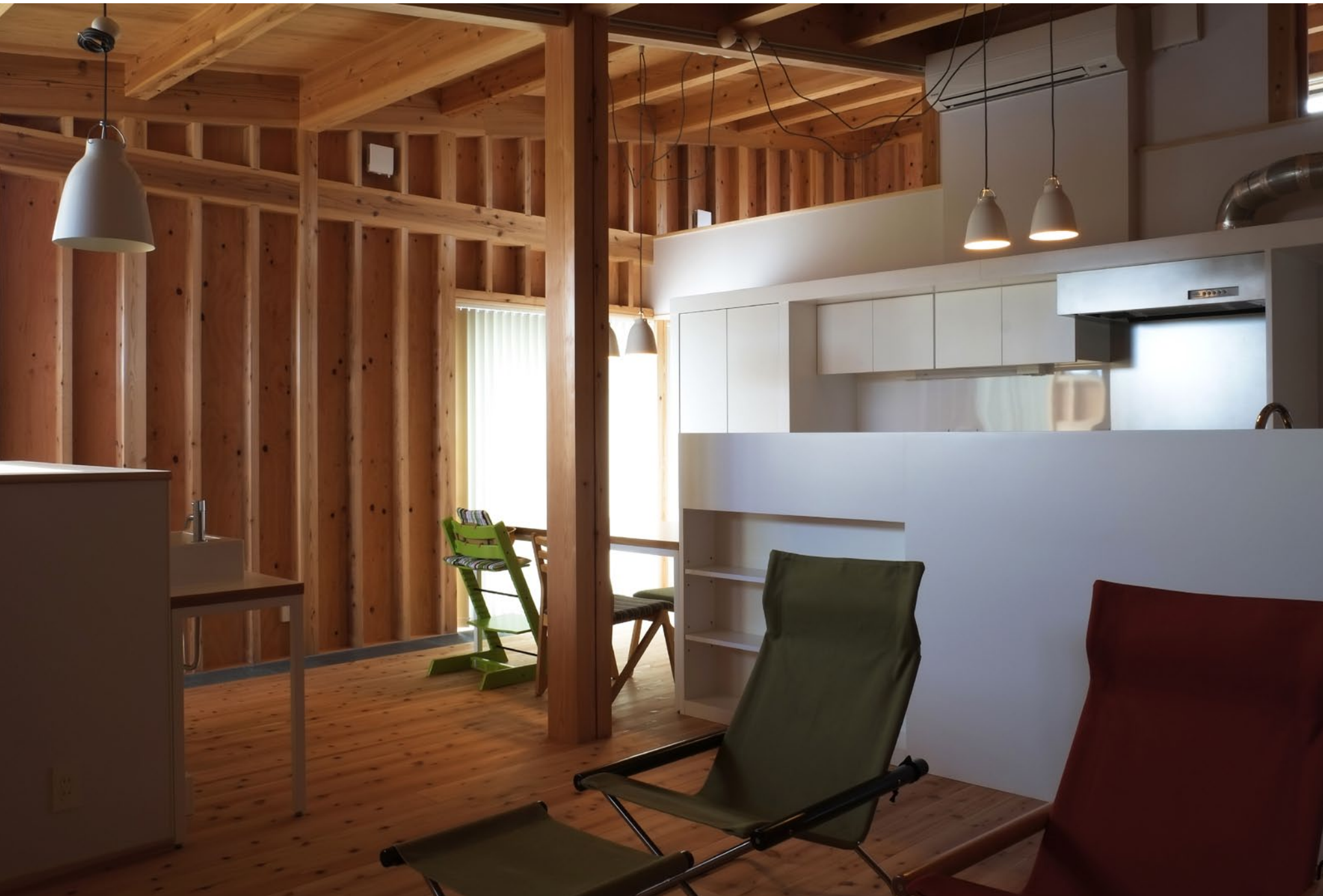
「あらわしの家」2階LDK。木の暖かみを感じられる空間になるよう、外断熱構法を用いて室内はすべて構造材現しとしている。
